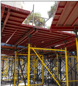
قالب بندی سقف: میز پرنده
