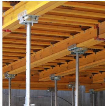
قالب سقف فلکس (رویه پلای وود با پشت بند H20)
