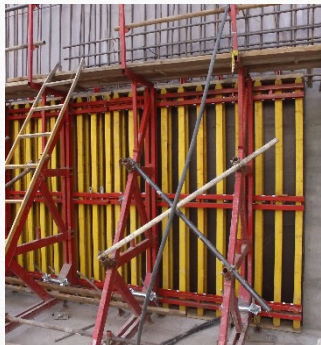
قالب دیوار یک طرفه هوپاد (رویه پلائی وود با پشت بند H20)
