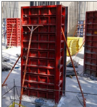
قالب بندی ستون: قالب هوپاد
