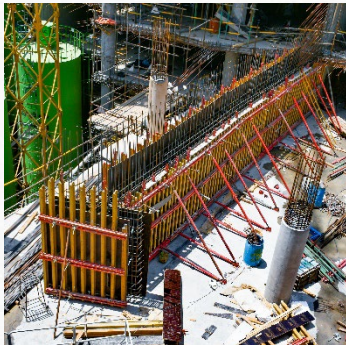
قالب دیوار دوطرفه هوپاد (رویه پلائی وود با پشت بند H20)
